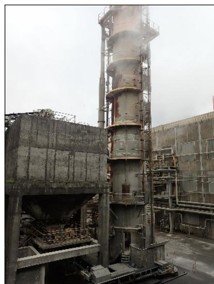
Four à chaux pour le chaulage nécessaire pour éliminer les impuretés
